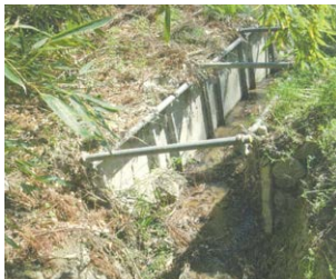
【蟹沢】単管による土留め
