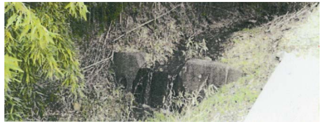
【マムシ沢】設置年度不明 既設床固工
