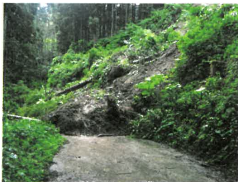
土砂崩れ現場
