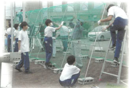
裾花中学校のトンネルの作成作業
