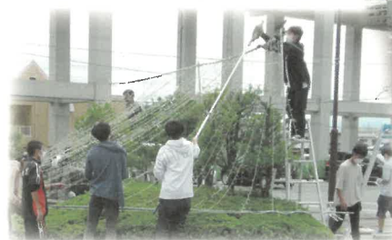
植木（前部）の設置作業中の長野工業高校生
