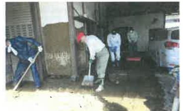
長沼地区での泥出し作業
