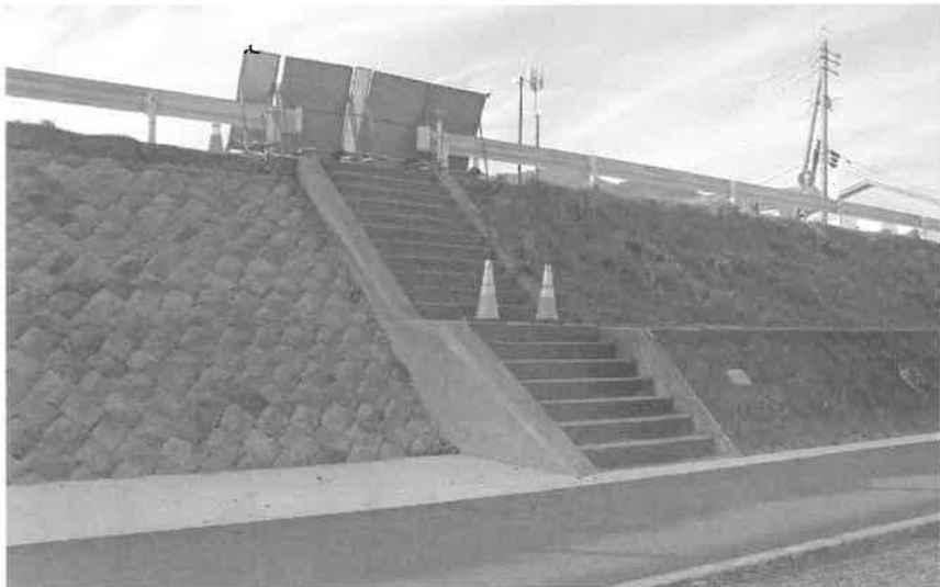
高水護岸下階段
