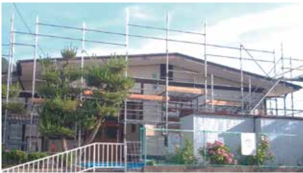
6月20日 足場作業終わる
